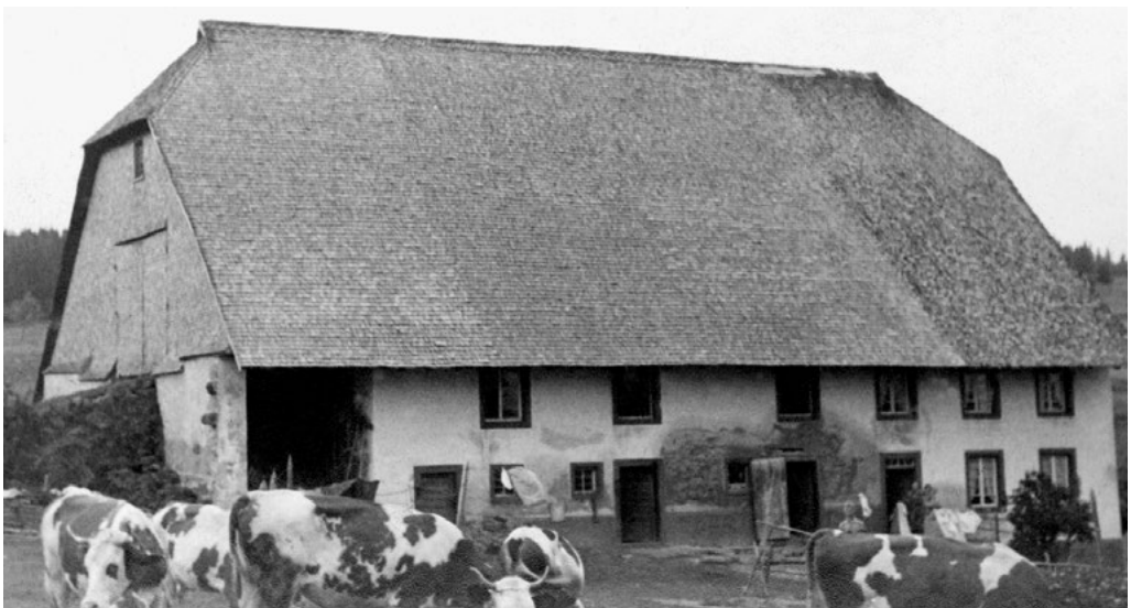
Der Gemeindehof der Familie Kienzler in Schonach hatte bis in die 1950-er Jahre ein Schindeldach.
