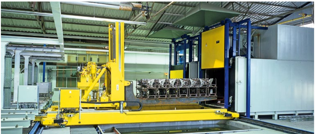
Wärmebehandlungsanlage der Firma REINHARDT für Aluminiumussteile.
