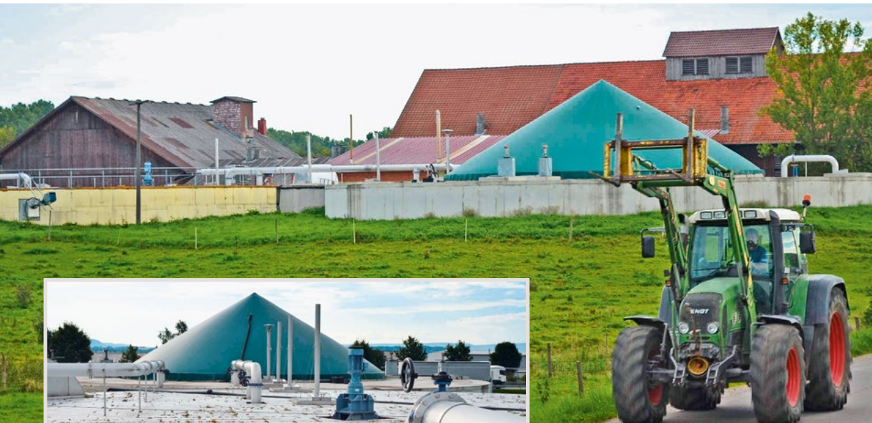
Die 2002 in Donaueschingen in Betrieb genommene Biogas-Pilotanlage verwertet in vier Rohrfermentern jährlich 8.000 Tonnen Lebensmittelabfälle aus Krankenhäusern. Das dabei entstehende Gas wird verbrannt: Über 700 Vier-Personen-Haushalte würden dadurch mit Strom und 210 zusätzlich mit Wärme versorgt, betonen die Betreiber. Die Besonderheit der vom ABB-Konzern finanzierten Pilotanlage steckt im „Futter“ für die Bakterien. Eine Monovergärung reicht, das bedeutet: Es werden nur Speisereste benötigt.
