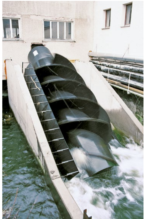
In Bräunlingen wurde 2002 ein Wasserkraftwerk mit Schnecke statt Turbine realisiert.
