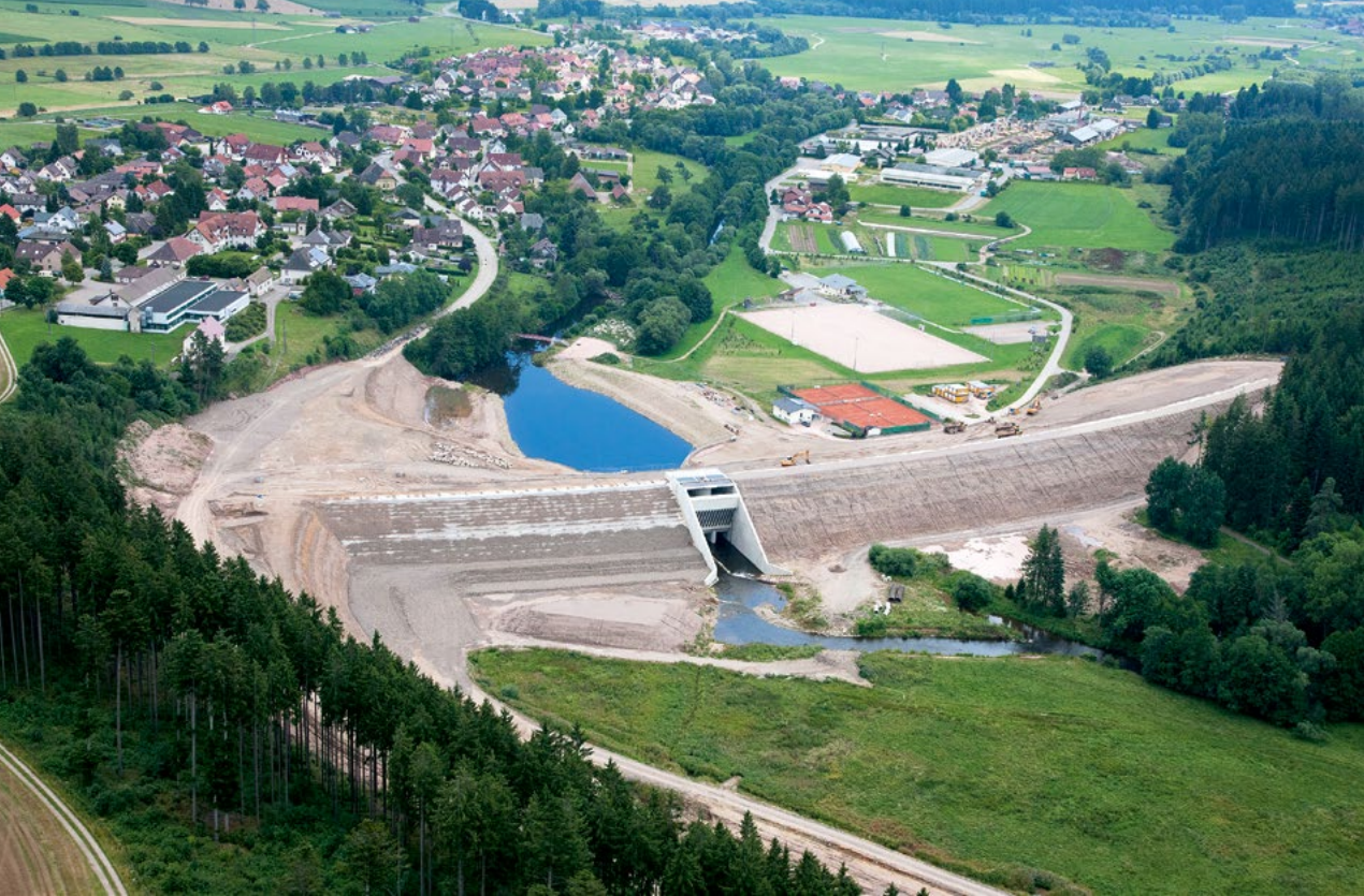
Das Hochwasserrückhaltebecken Wolterdingen im Luftbild, die Aufnahmen entstanden im August 2010. Das gesamte Erdmaterial wurde einem Steinbruch in der Nähe des Staudammes entnommen (unten).
