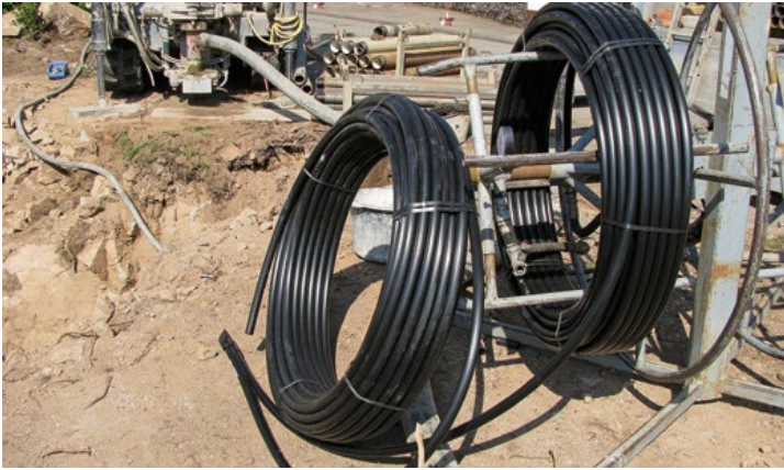
Erdwärmesonde bzw. Sondenschläuche auf der Haspel vor dem Einbau in das Bohrloch
